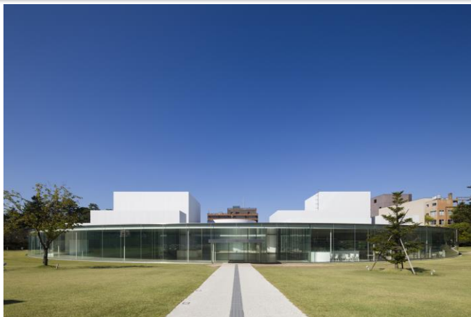
撮影：渡邊修 提供：金沢 21 世紀美術紀館
