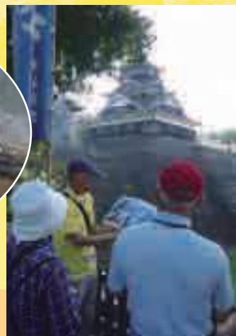
ボランティアガイド案内による熊本城復興工事視察
