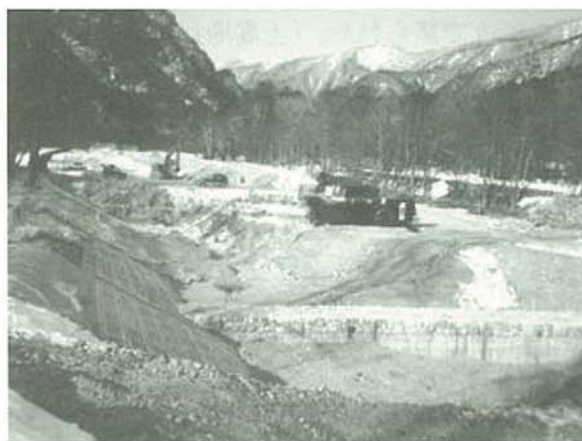
閑散期の冬期に大規模な工事が行われている
